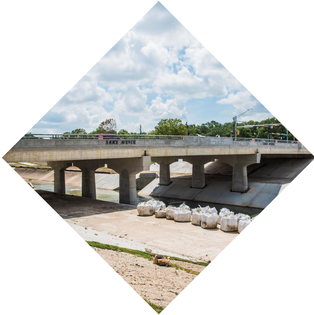
Imagen: puente de Rice en Brays Bayou, Proyecto de Control de Inundaciones.
